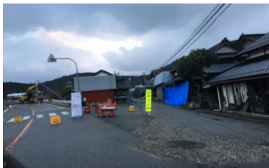
写真1 通行止めと迂回路の表示 建物被害も見える
