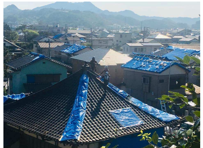
ブルーシート掛けには技術が必要。高い技能を持ったボランティアが育ってきている（鋸南町）
